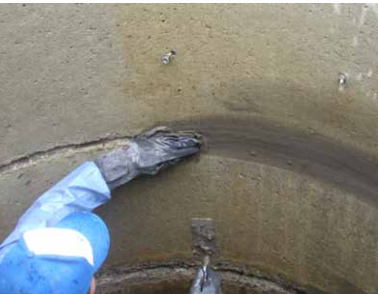
Laidžių siūlių remontas
