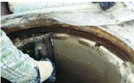
4. Paviršiaus reprofiliavimas su VANDEX RAPID S
