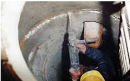
1. Siūlių ir įskilimų paruošimas
