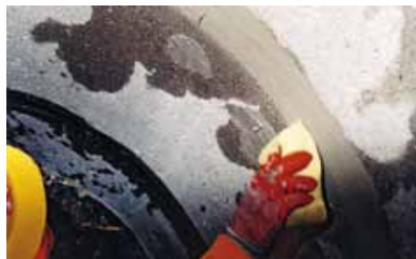
5. VANDEX RAPID S išlyginimas kempinėle
