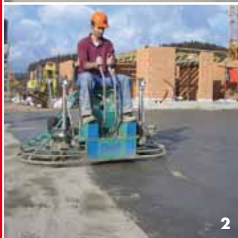
2 Milteliai mechaniškai įtrinami į paviršių.
