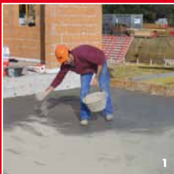
1 VANDEX SUPER milteliai išbarstomi ant šviežiai išlieto betono.
